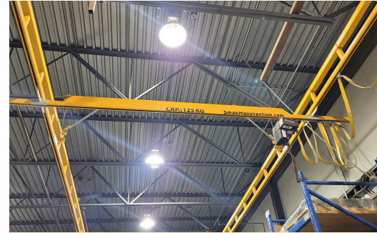
PONT ROULANT SMAK MANUTENTION AVEC 2 PALANS CAP. 125 KG
