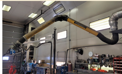
EXTRACTEUR DE FUMÉE PLYMOVENT AVEC BLOWER
